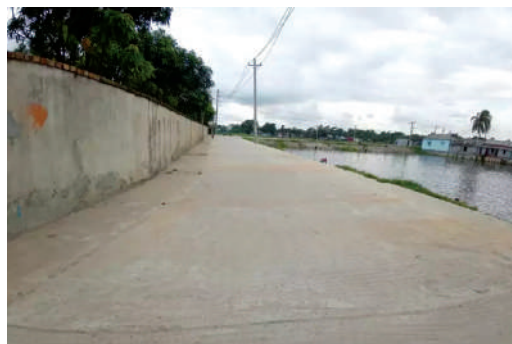
জাইকার অর্থায়নে নির্মিত ২৪নং ওয়ার্ডের টি হোসেন রোড হতে ২৬নং ওয়ার্ডের তালতলা পর্যন্ত আরসিসি ড্রেনসহ আরসিসি রাস্তা নির্মাণ।
