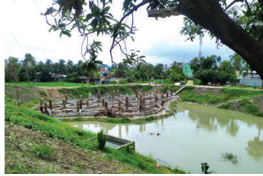
সিদ্ধিরগঞ্জ লেক এর চলমান সৌন্দর্যবর্ধন কাজ।
