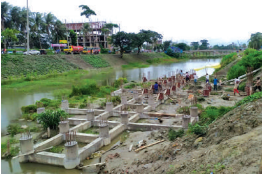
সিদ্ধিরগঞ্জ লেক এর চলমান সৌন্দর্যবর্ধন কাজ।
