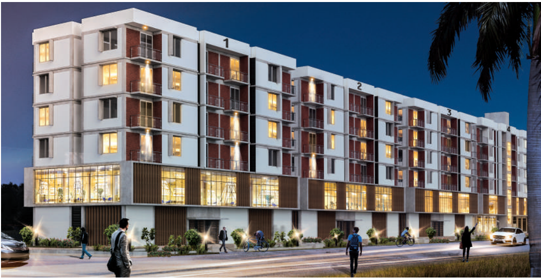
১১নং ওয়ার্ডে বরফকল মাঠ সংলগ্ন নির্মাণাধীন করবী সিটি প্লাজা-২, ৩, ৪ ও ৫ বাণিজ্যিক কাম আবাসিক ভবন।
