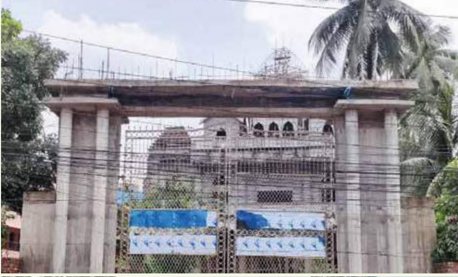
রামকৃষ্ণ মিশনের গেইট (নির্মাণাধীন), ওয়ার্ড-১২
