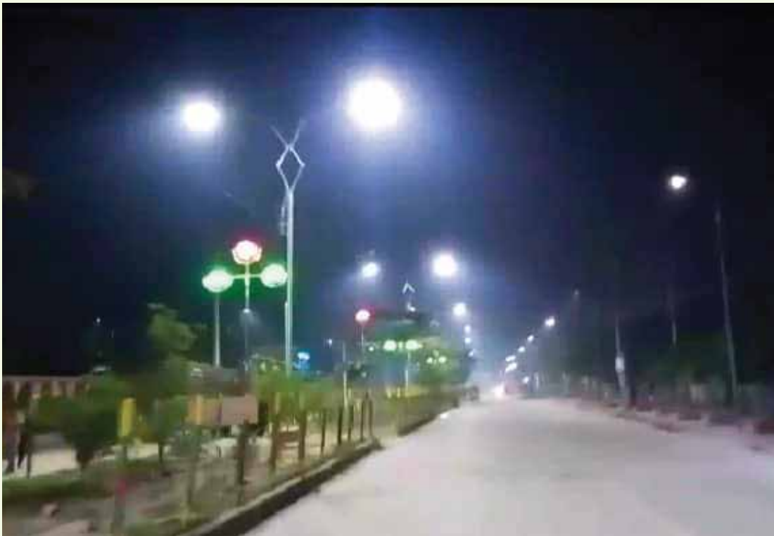
নারায়ণগঞ্জ, কদমরসুল ও সিদ্ধিরগঞ্জ অঞ্চলে এলইডি স্ট্রিট লাইট স্থাপন প্রকল্প
